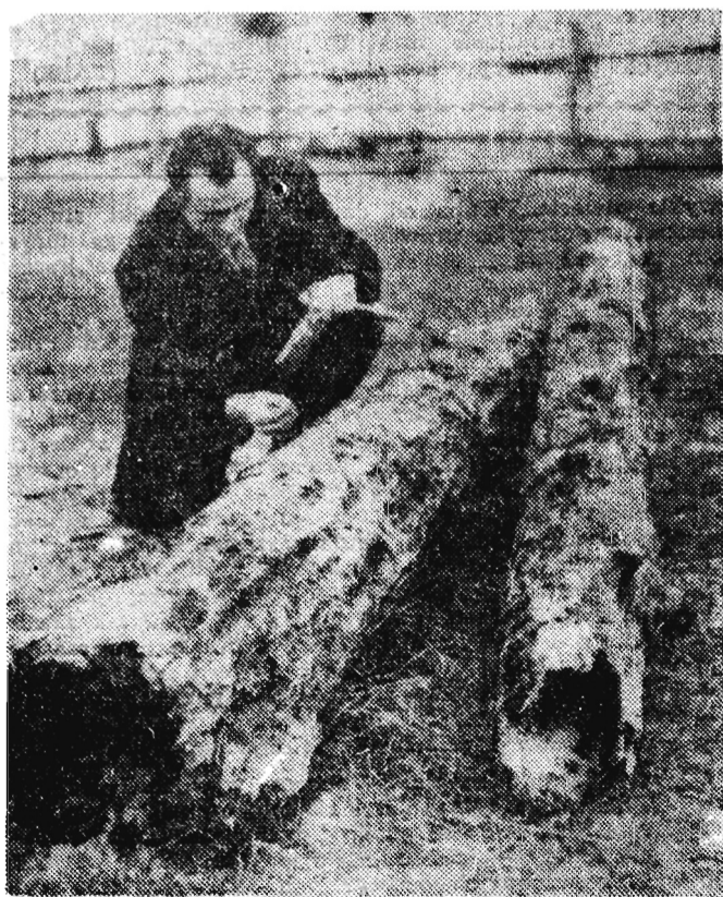
W czasie budowy szkoły na Bielanych w Toruniu odkopano dobrze zachowane drewniane przewody wodociągowe. Jak twierdzą konserwatorzy pochodzą one z XIV w. System wodociągowy długości 1,5 km zbudowany z wydrążonych pni doprowadzał niegdyś wodę do miasta.
