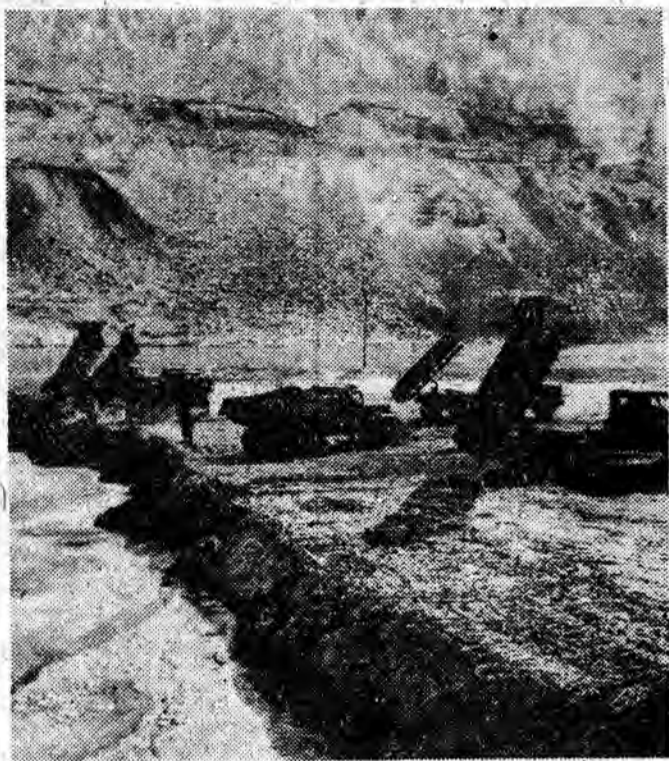
Budowniczość krasnojarskiej hydroelektrowni osiągnęła wiele sukcesów przygotowując się do decydującego szturm na potężny Jenisiej. Na zdjęciu: budowa nasypu pod fundamenty potężnej krasnojarskiej hydroelektrowni.
