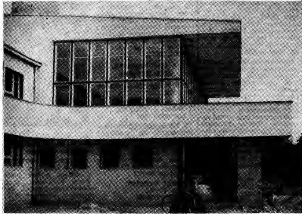
Na zdjęciu: budynek teleostacji na Suchoj Górze.
