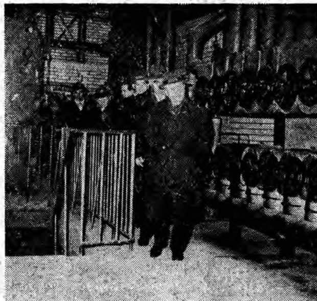
W dniu 15 grudnia 1962 r. wicepremier Julian Tokarski dokonał otwarcia Zakładu Produkcji Elementów Budowlanych na Stępkach w Warszawie. Zakład produkuje prefabrykaty budowlane z płyt dymnicowych, pochodzących z sąsiedniej Elektrociepłowni na Stępkach. Zdolność produkcyjna zakładu, który posiada pełną automatyzację, będzie wynosiła 92 miliony jednostek ceramicznych. Prefabrykaty gazobetonowe będą tańsze o 50 procent od tradycyjnych. CAF — fot. Uchymiak
