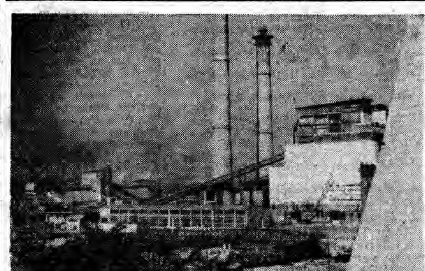
Budownictwo elektrowni Turów — realizatorzy „Akcji 400” zameldowali dnia 2 grudnia 1962 r., że energia z drugiego kolebnego turbosopu została przekazana do sieci państwowej. Tym samym, budownictwo Turowa zamknęło ostatnie trudny okres realizacji zobowiązań wykonanych z „Akcją 400”.
