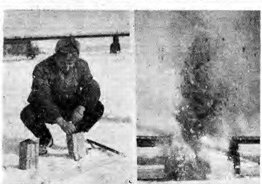
Jednostka sapercka wysadza lody na Wiśle. Na zdjęciu: z lewej — przygotowanie ładunku trotylu do wysadzania lodów. Z prawej — wybuchy ładunków niszczą pokrywę lodową. CAF — fot. Szyperko
