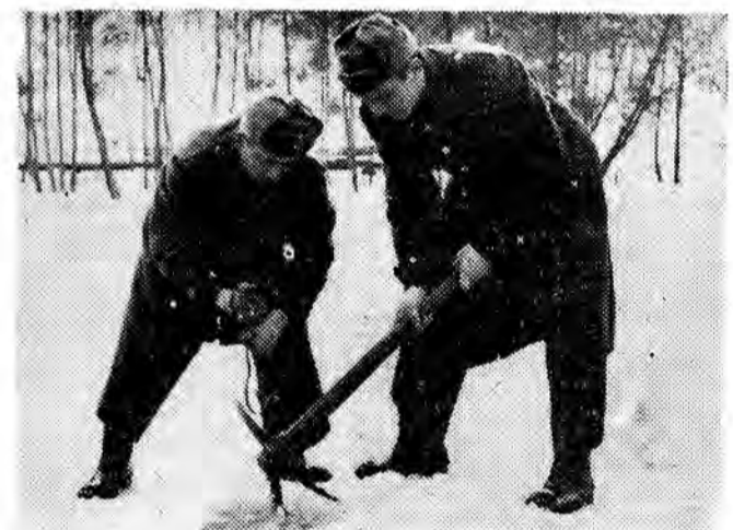
Saperzy rzeszowskiej Jednostki KBW zlikwidowali zator na Wisłoku w rejonie Babicy, ochraniając most przed zniszczeniem. Na zdjęciu: moment zakładania ładunków wybuchowych. Fot. WACŁAW KRUSZEWSKI
