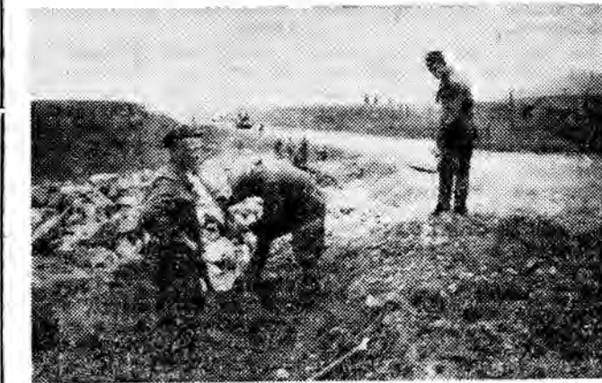
Podczas budowy drogi w Bieszczadach.
