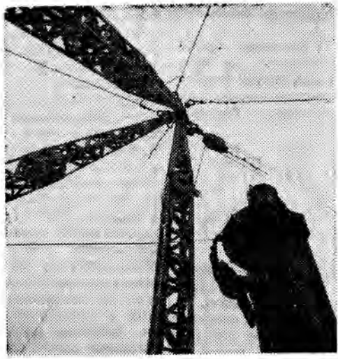
Kilka dni temu zaczęto budowę rotundy gmachu PKO przy zbiegu Al. Jerolimskich i ul. Marszałkowskiej w Warszawie. Konstrukcja gmachu w kształcie kołystym będzie jedyną budową tego typu w Warszawie. Głównym projektantem jest mgr inż. J. Jakubowicz z Miastoprojektu-Śródmieście, wykonawcami zaś tej budowy przedsiębiorstwa PBM-ADM i warszawski Mostostal. Kubatura budynku wyniesie 20 000 m sześć, a sama jego konstrukcja będzie miała ponad 100 ton aluminium. Wysokość budowli ponad poziom ulicy ma mieć 13,5 m. Obecnie trwają prace montażowe konstrukcji budowy. Prowadzi je mgr inż. St. Piotrowski z Mostostalu Warszawa. Konstrukcja tego oryginalnego gmachu ma być gotowa w ciągu dwu miesięcy, cały gmach zostanie oddany do użytku w drugim półroczu 1964 r. Obecnie montuje się słup środkowy konstrukcji, który waży 7,2 tony. Ma on służyć do celów poczty pneumatycznej, kanalizacji gmachu oraz aklimatyzacji. Na zdjęciu: Na budowie rotundy. CAF - fot. Tyminski
