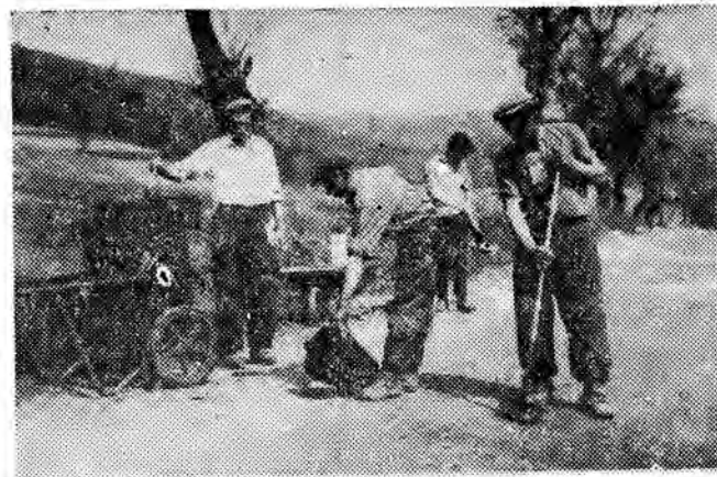
Grupa robotników pod kierownictwem dróżnika ob. Jana Fortuny „łata” dziury na szosie w okolicy Korytnik, w powiecie przemyskim. Bieżąca konserwacja dróg zda na pewno egzamin i przyczyni się do zmniejszenia nakładów na cele komunikacyjne. Fot. ZZ
