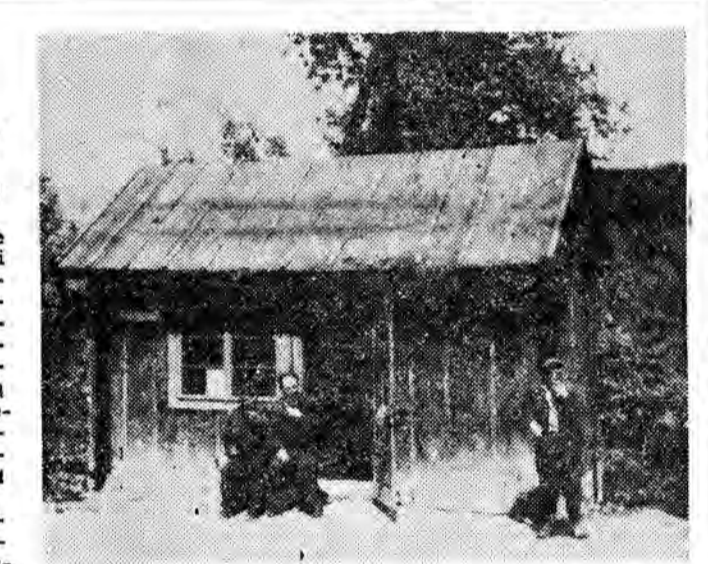
W tej małej budce mieści się nowoczesna i jedyna w naszym przemyśle naftowym aparatura do zdalnego centralnego sterowania koników pompowych.
