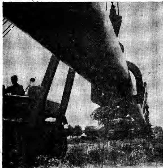
Budowniczo-rurociągu „Przyjaźń” postanowili wykonać do dnia 20 lipca połączenia rurociągu na granicy wschodniej i zachodniej z odcinkami ułożonymi na terytorium ZSRR i NRD. Wykonanie tego zobowiązania jest ważnym etapem w harmonogramie budowy przewidywanego uruchomienia rurociągu przed nadejściem mrozów.
