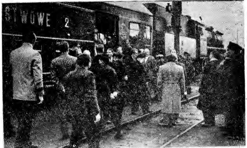
Stypendyści DOKP zapoznają się z postępem prac przy elektryfikacji linii kolejowej.
