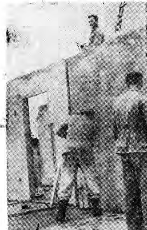
Montaż domów z prefabrykatów. Jeden dźwig, kilku robotników, ustawiających we właściwym miejscu elementy, a to cała tajemnica powodzenia i procesu budowy.
