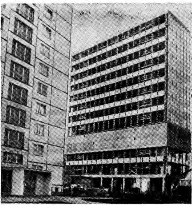
W NRD Na zdjęciu: budowa „Domu Nauczyciela i Naukowca” przy placu Aleksandra w Berlinie. CAF
