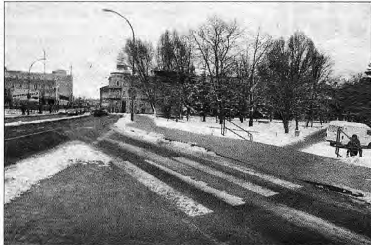
Prawdopodobnie McDrive powstanie na placu św. Floriana.
