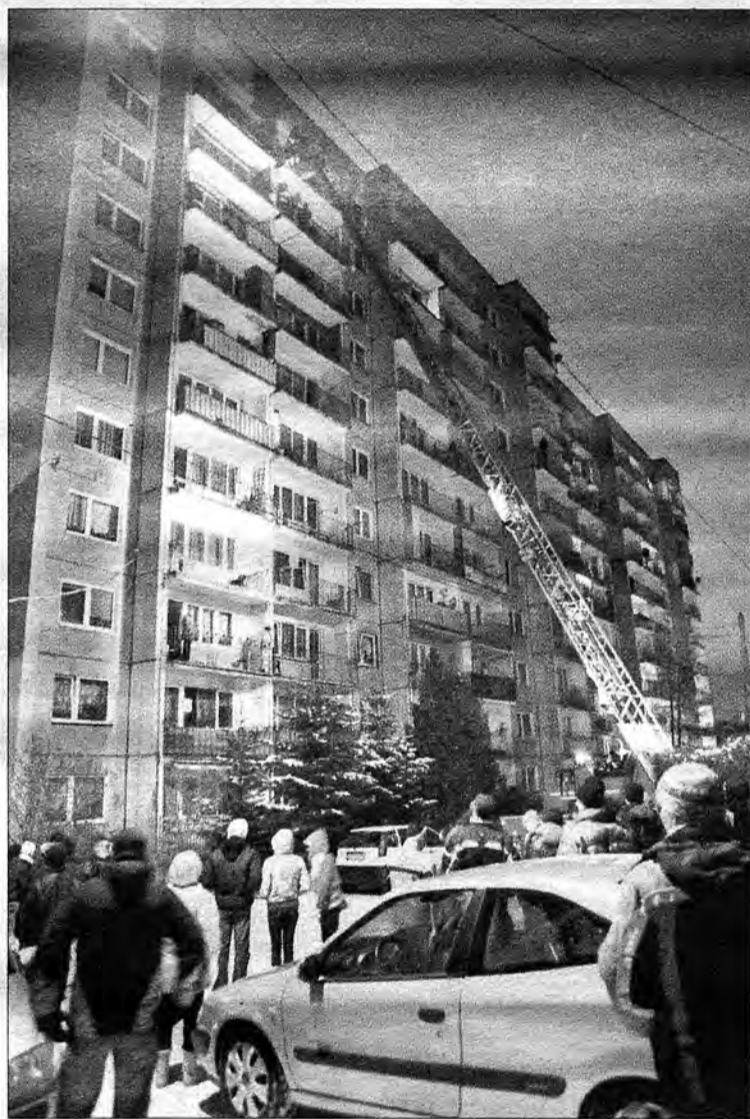
Pożar wybuchł między ścianą dzielącą szyb windy a klatką schodową, obłożoną płytą pilśniową.
