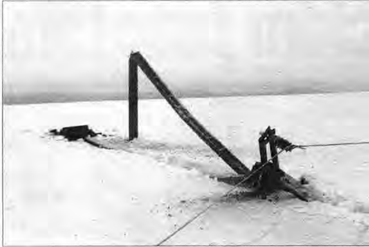
W gminie Narol pod ciężarem lodu złamało się ponad 20 słupów. Na terenie RZE Tomaszów Lubelski ponad 200.
