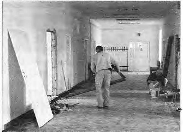
Wymiana drzwi uszkodzonych podczas włamania do gabinetów lekarskich.
