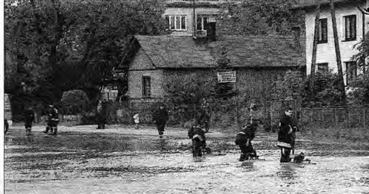
Ulica Skorupki w Cieszanowie po przejściu wielkiej wody.
