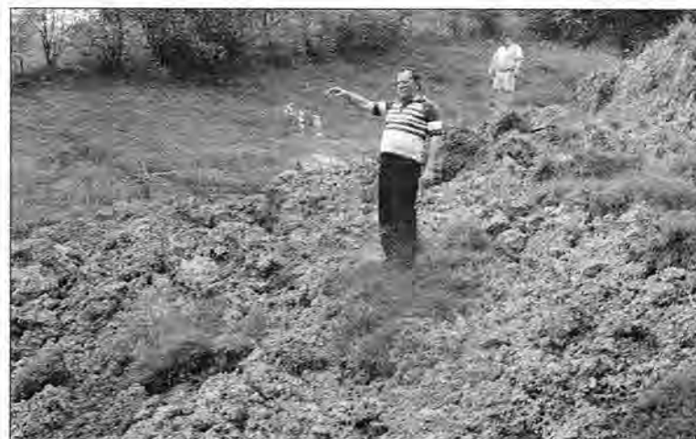
Błotna lawina zniszczyła teren Kruszyńskich.
