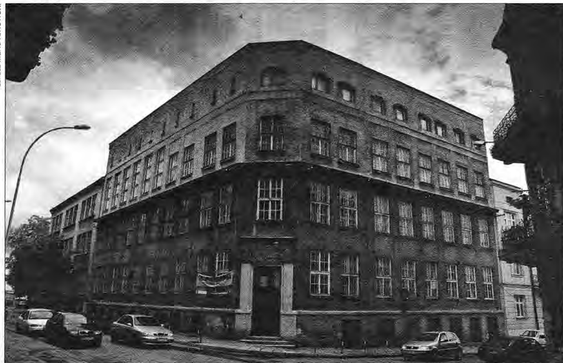
W budynku po byłej „odzieżówce” przy ulicy Tarnawskiego powstanie około 25 mieszkań.
