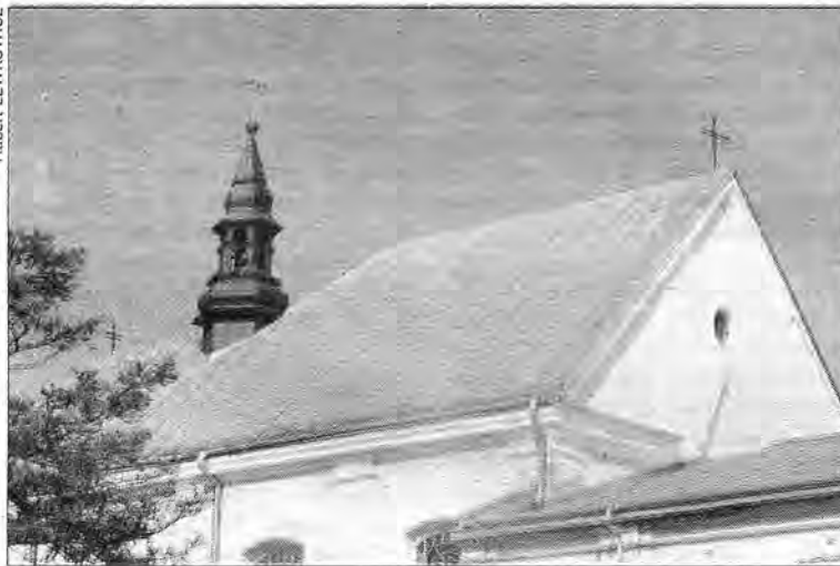
Remont dachu i konstrukcji dachowej to koszt około 270 tys. zł.
