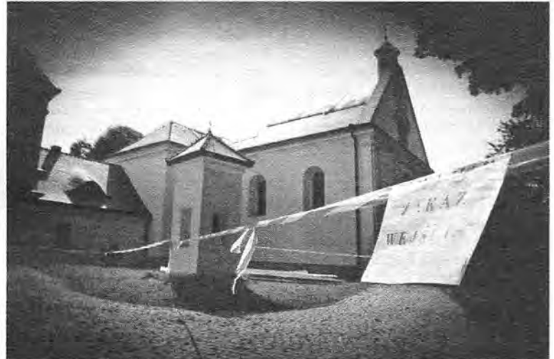
Niedawno wyremontowany dach kościoła czeka na odbudowę po pożarze.
