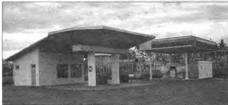
Nowa stacja paliw przy ul. Lwowskiej
