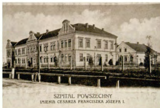
Szpital powiatowy przy ulicy 3 Maja; początek XX wieku.
