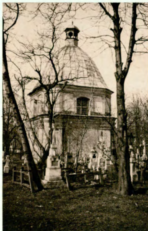
Cerkiew Zaśnięcia NMP i cmentarz przy ul. Kraszewskiego, sprzed 1939.
