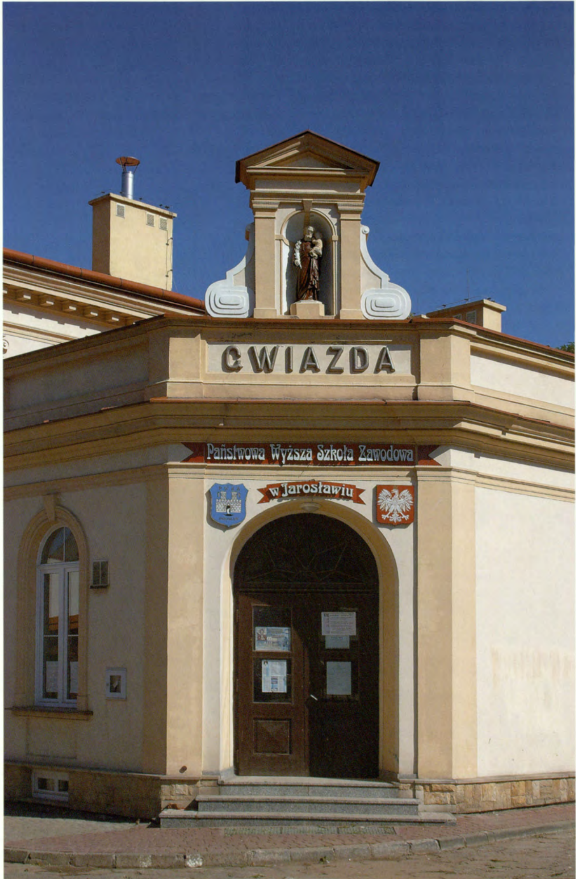
Budynek Towarzystwa Rzemieślniczego „Gwiazda” przy ulicy Franciszkańskiej; obecnie Państwowa Wyższa Szkoła Zawodowa im. ks. B. Markiewicza.
